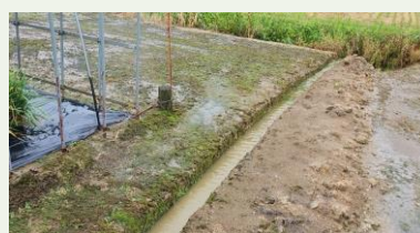
写真4 明きょに水が流れている様子
