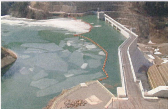
平成14年3月18日 試験湛水 サーチャージ水位到達
