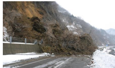
平成26年1月25日福島町にて土砂崩れにより道路に土砂が流出し6戸の孤立集落が発生。
