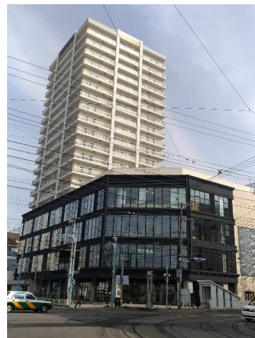
函館市中心市街地活性化基本計画により整備された本町地区の複合施設「シエスタハコダテ」
