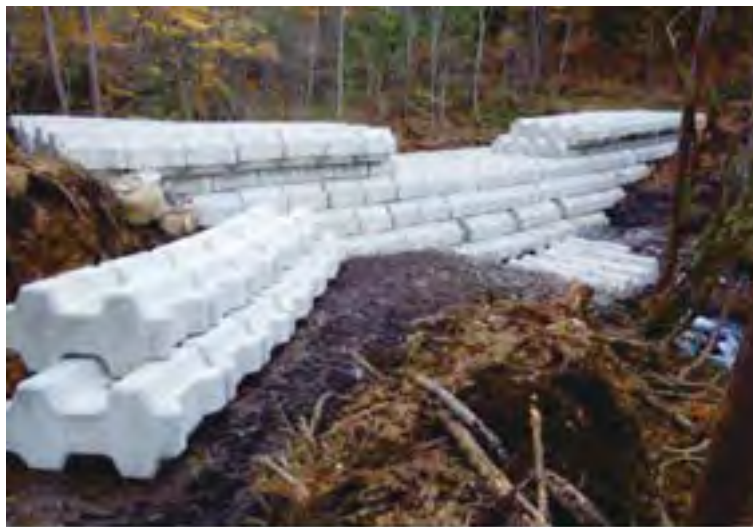
図 5-2 鹿ノ瀬川に設置したブロック堰堤
