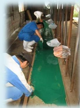
飼槽表面へのレジンコンクリート施工
