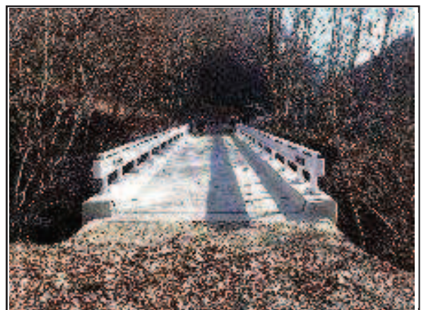
掛け替えられた橋梁
