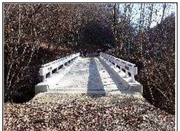
掛け替えられた橋梁
