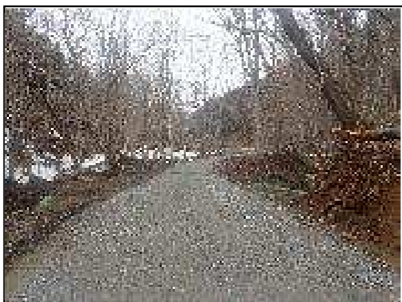
林業専用道新設
