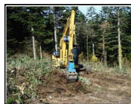
機械作業による地拵え
