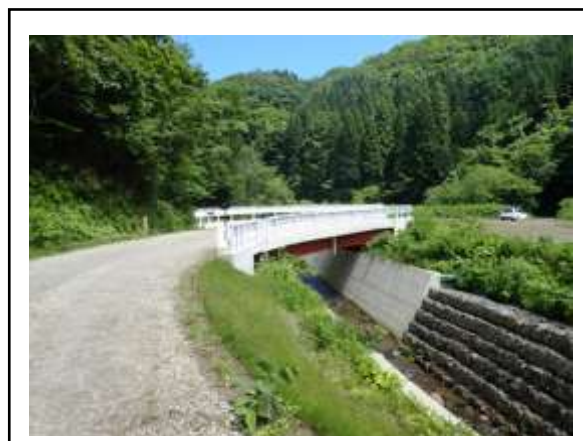
基線林道 木の子線(木の子1号橋)
