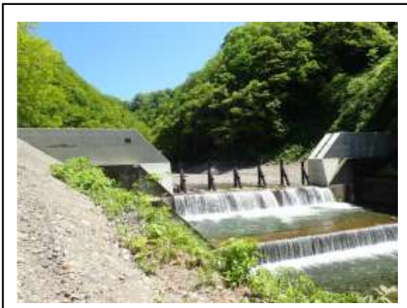
保安林内治山施設(治山ダム)
