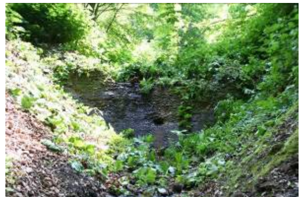
管内最古の治山ダム(八雲町上の湯)
