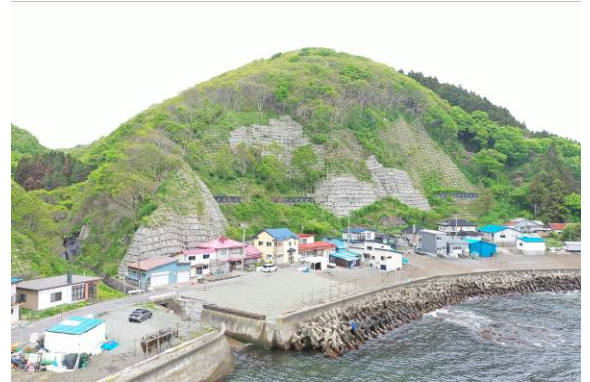
山崩れを防止する山腹工(函館市豊浦地区)
