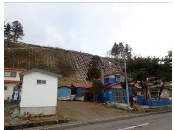
法枠工(鹿部町字大岩)
