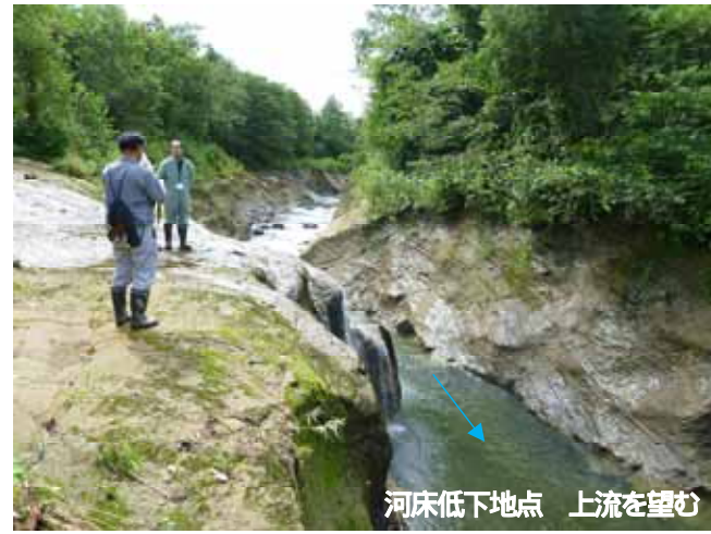
河床低下地点 下流を望む
