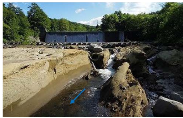
2号砂防ダム直下 H24 撮影
