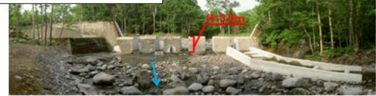
写真-1 布部川1号砂防えん堤スリット化 H19.6撮影
