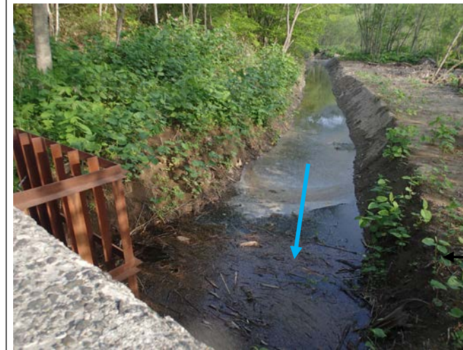
2号砂防ダム魚道上流の状況 (H26.5.29撮影)
