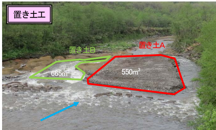
置き土実施後の状況 (H26. 5. 16 撮影)
