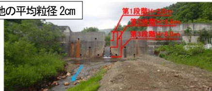
写真-2 ポンポンニタシベツ川1号砂防えん堤スリット化 H25.6撮影
