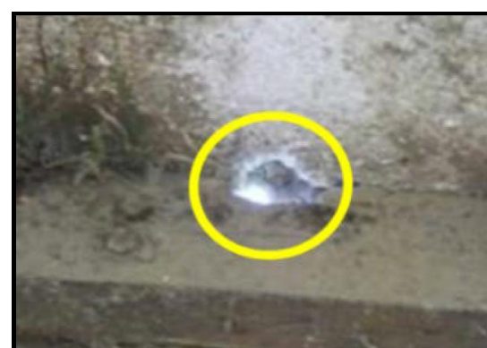
壁等の破損修繕
