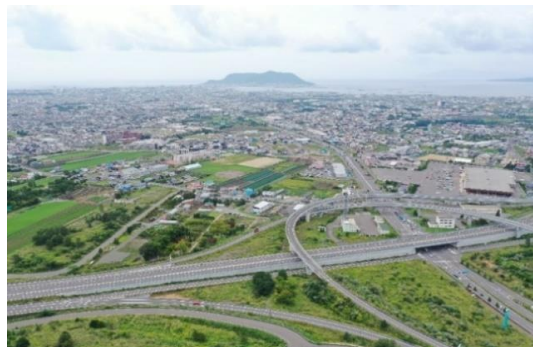
「函館・江差自動車道」と「函館新道」をつなぐ函館IC
